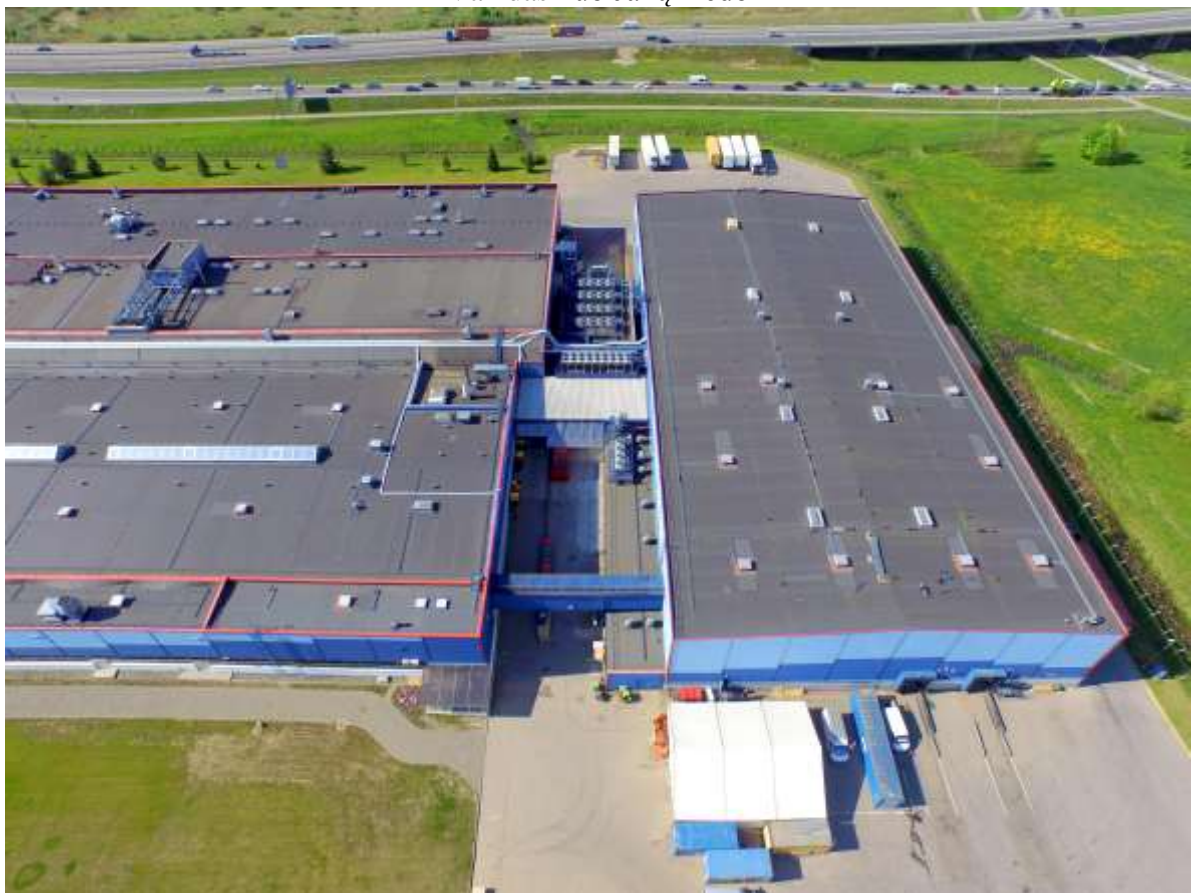
Rekonstruojamo sandėlio vaizdas iš pietų pusės
