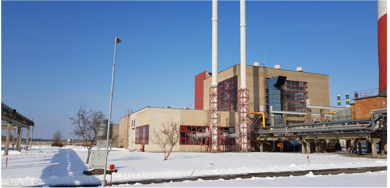
Rekonstruojamos Lypkių katilinės vaizdas iš pietų pusės
