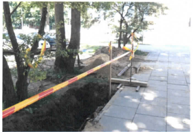
8. Komunikacijų pajungimo duobė iš PR
