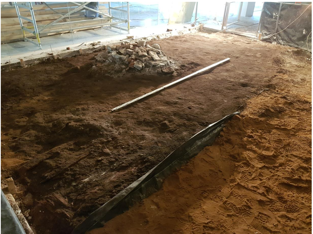
4. Klaipėdos piliavietė 2018 m., perkasa 1, nuskustas paviršinis sluoksnis iš PR.
