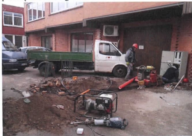
3. Kasama elektros kabelio trasa. Vaizdas iš P.
