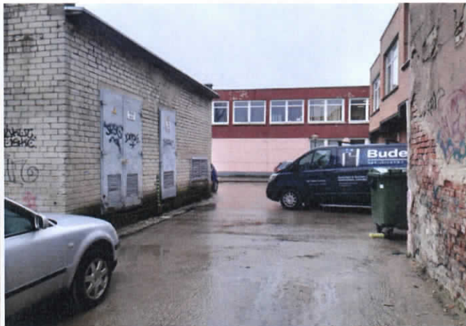
2. Planuojamo tiesiti elektros kabelio įvado į pastatą H. Manto g. 36A vieta. Vaizdas iš V.
