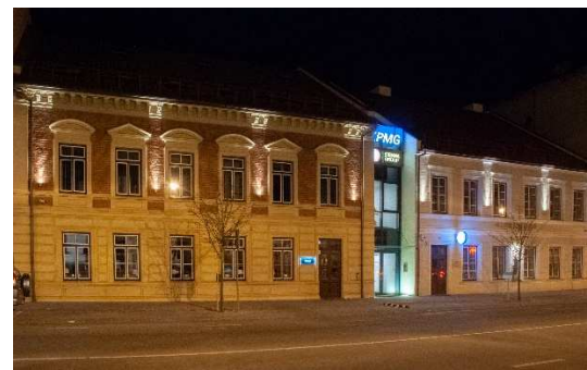
Pav.2.16. Fragmentiškai apšviestas fasadas
