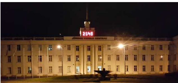
Pav.2.17. Neišraiškingas fasado apšvietimas
