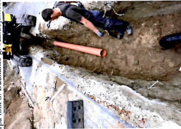
7. Vykdomi lietaus nuotekų tinklų klojimo darbai iš P-PV
