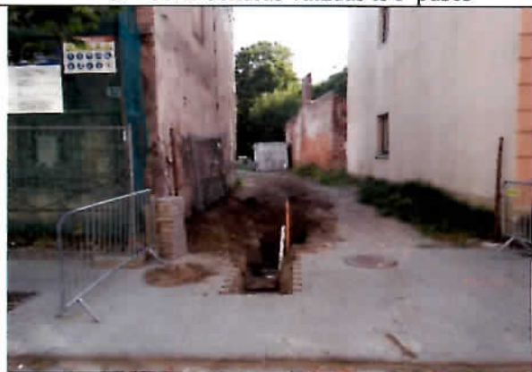
11. Tr. 1 bendras vaizdas iš PV pusės
