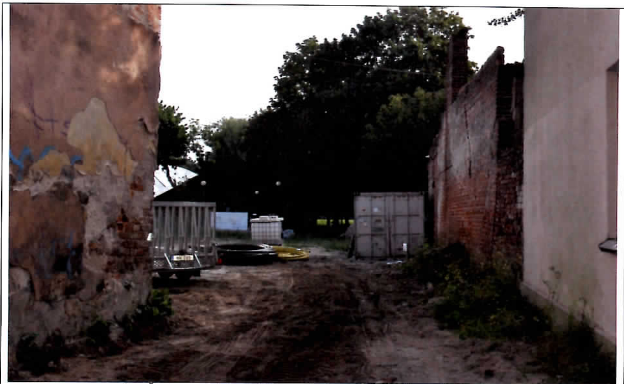
25. Žvalgymų vietos vaizdas po tyrimų. Dujotiekio tranšėjos užkastos
