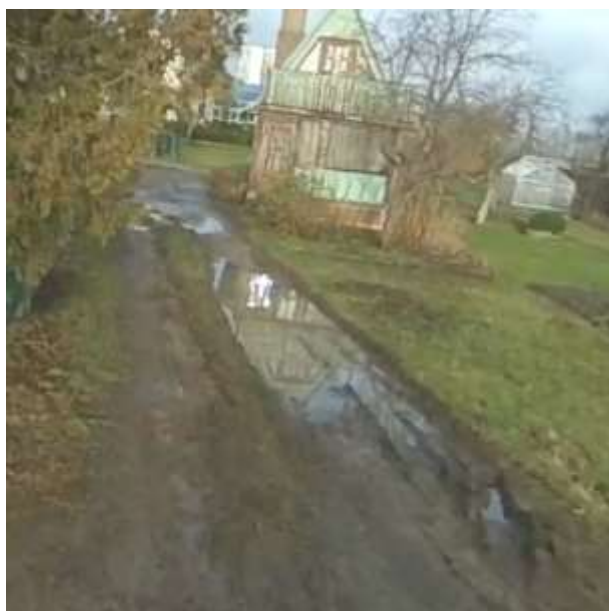
1 pav. Paviršinio lietaus nuotekų sankaupos gatvės važiuojamojoje dalyje
