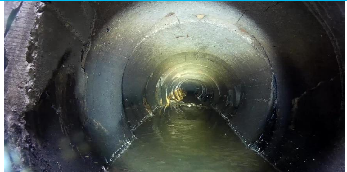
Suskilusius ir deformuotus vamzdynus, kuriems kyla rizika sugriūti
