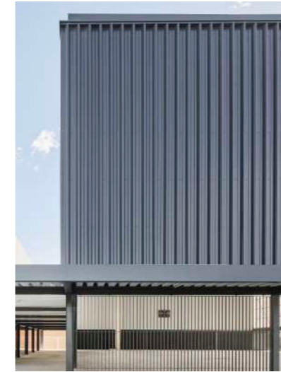
1. Sporto salių tūriai: sandwich paneliai su skardos kasečių/lakštų/lamelių apdaila
