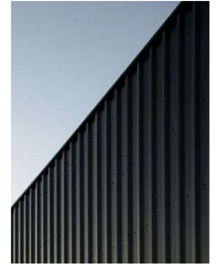
1. Sporto salių tūriai: sandwich paneliai su skardos kasečių/lakštų/lamelių apdaila
