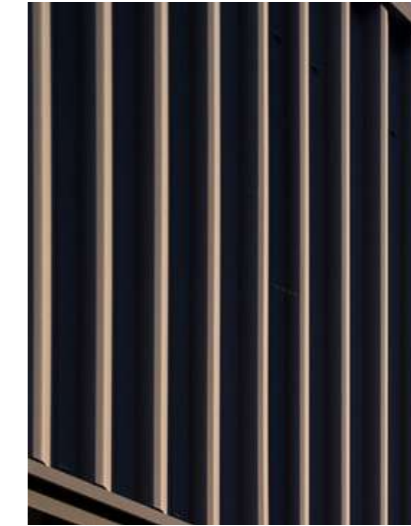
1. Sporto salių tūriai: sandwich paneliai su skardos kasečių/lakštų/lamelių apdaila
