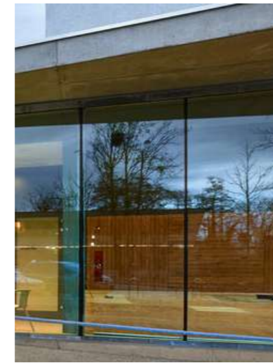
2. Įėjimo fasadai: aliuminio - stiklo konstrukcijų fasadinė sistema
