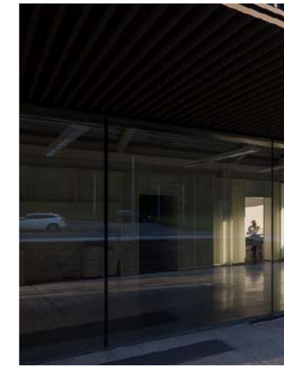
2. Įėjimo fasadai: aliuminio - stiklo konstrukcijų fasadinė sistema
