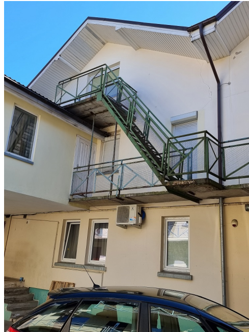
FOTO FIKSACIJA - FASADAS TARP AŠIŲ 3-1 (VIDINIS KIEMAS)
