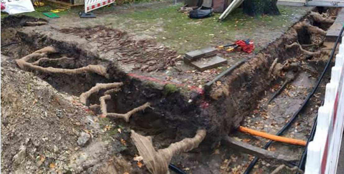
7 pav. Tranšėjos ir gatvės konstrukcijos lovio kasimo išsaugant medžių šaknis pavyzdys
