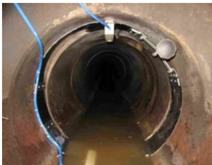
8 pav. Debitomačio montavimo schema
