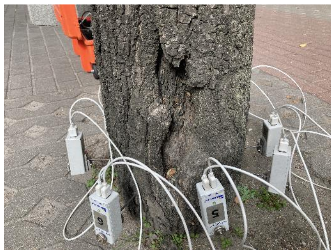
Kamieno mechaninis pažeidimas
