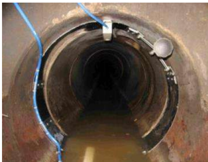
8 pav. Debitomačio montavimo schema
