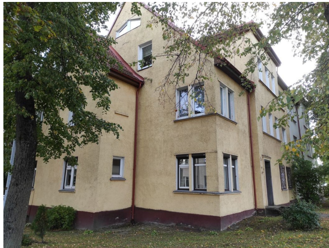
5 pav. Šiaurės rytų fasadas
