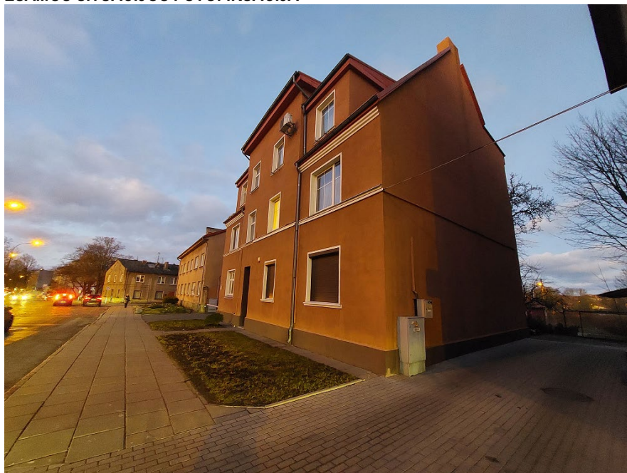
PIETRYTINIS IR ŠIAURĖSRYTINIS FASADAI; BANGŲ GATVĖ.
