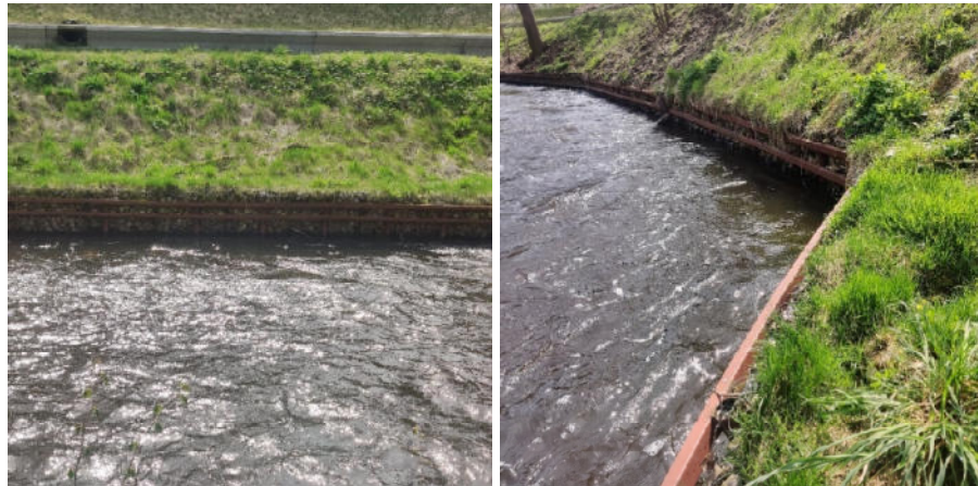
2 pav. Šlaitų tvirtinimas gabionais. Vilnios upė, Pūčkoriai, ties Pūčkorių atodanga
