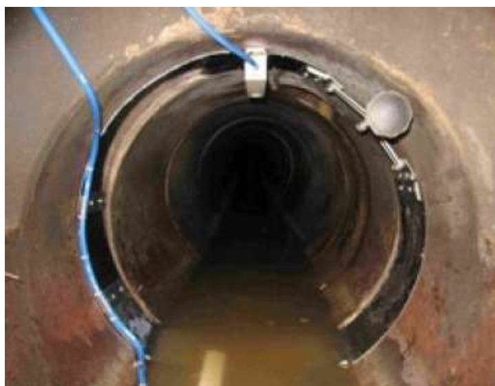
8 pav. Debitomačio montavimo schema
