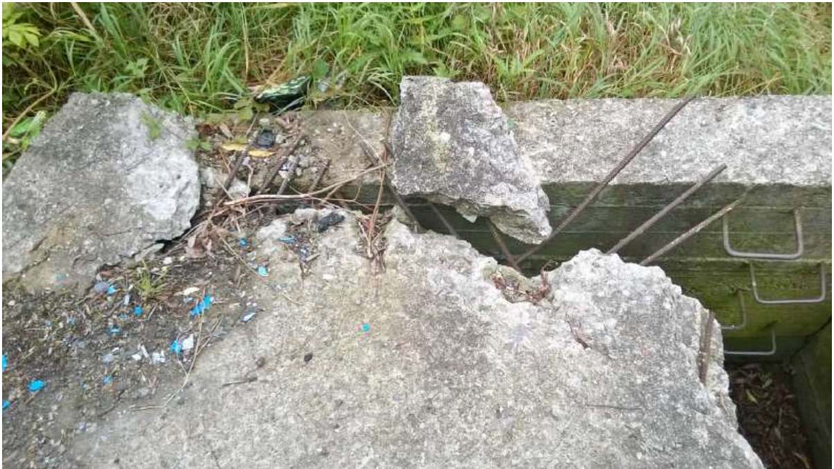
11 pav. Rekonstruojamoje kameroje matomi armatūros strypai
