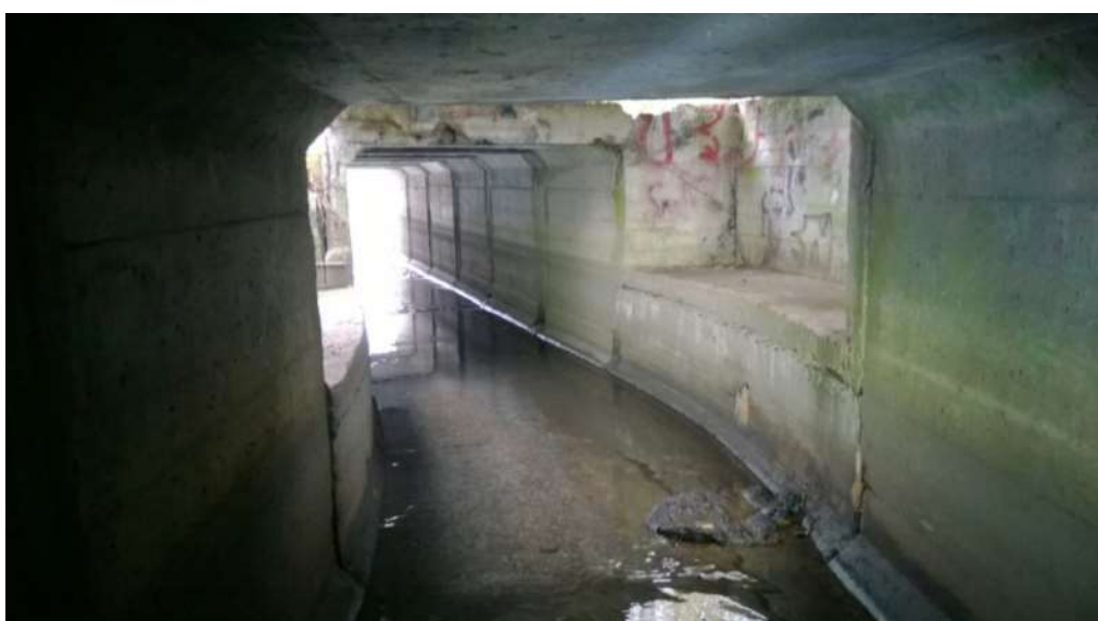
9 pav. Rekonstruojamos kameros vaizdas iš kolektoriaus
