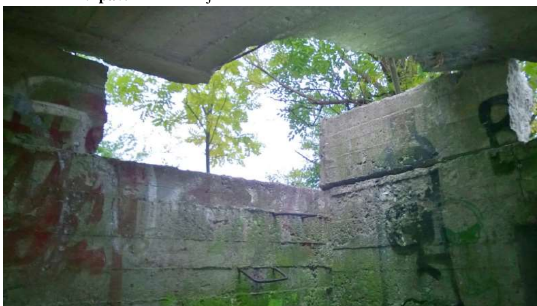
10 pav. Rekonstruojamos kameros pažeidimai
