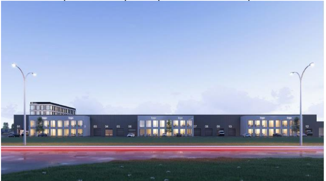
3 pav. Sandėliavimo paskirties pastatas. Vaizdas iš šiaurės pusės
