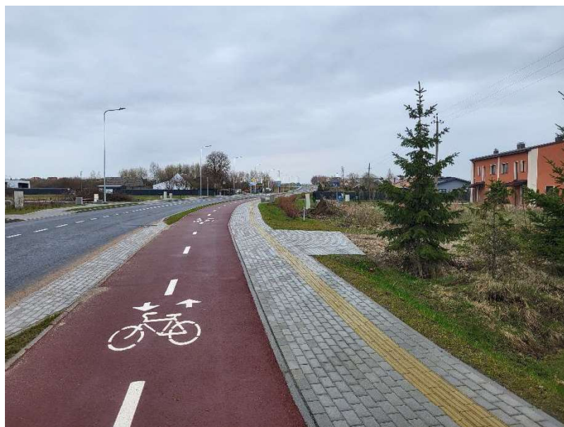
Pav. 2 Kleimiskės gatvė, Klaipėda. Planuojamo privažiavimo kelio (gatvės) vieta.
