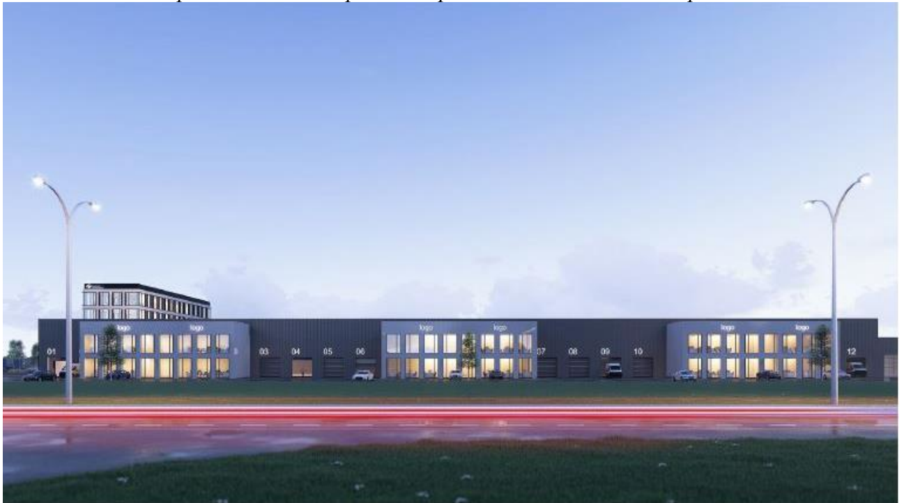
4 pav. Sandėliavimo paskirties pastatas. Vaizdas iš šiaurės pusės
