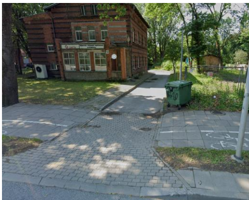
Esama situacija ties esamu įvažiavimu į planuojamą teritoriją (2024-06 fotografacija, google street view)
