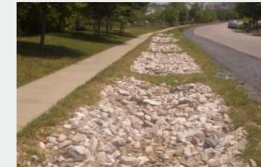
Užpildyti infiltraciniai grioviai
