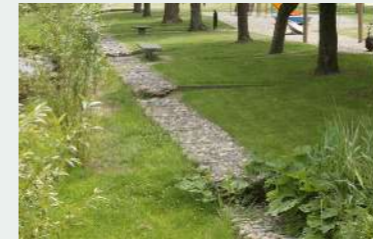
Užpildyti filtraciniai grioviai
