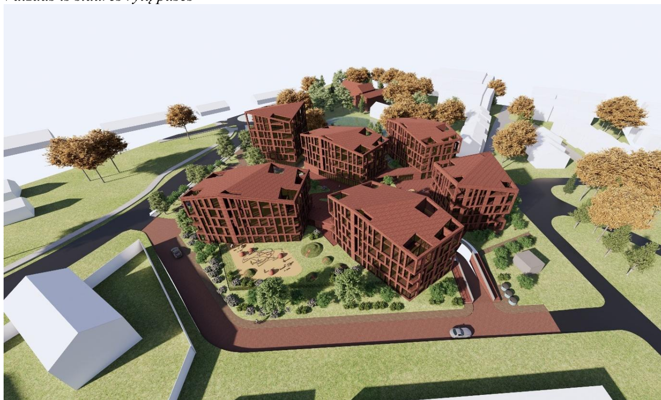
Vaizdas iš šiaurės rytų pusės
