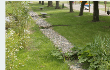
Užpildyti filtraciniai grioviai
