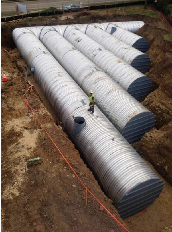
21 pav. Paviršinių nuotekų kaupyklų pavyzdžiai 5
