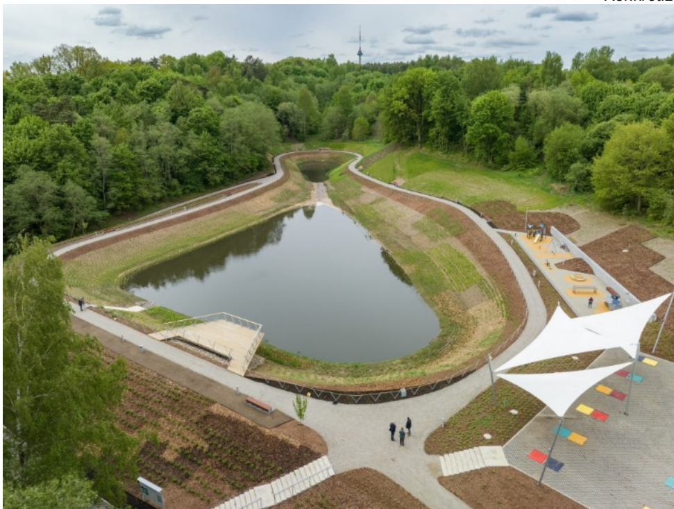
22 pav. Atvira paviršinių nuotekų kaupykla 6
