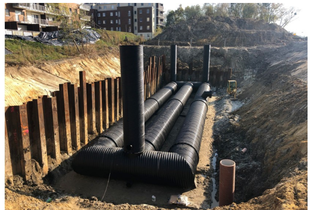
21 pav. Paviršinių nuotekų kaupyklų pavyzdžiai 5
