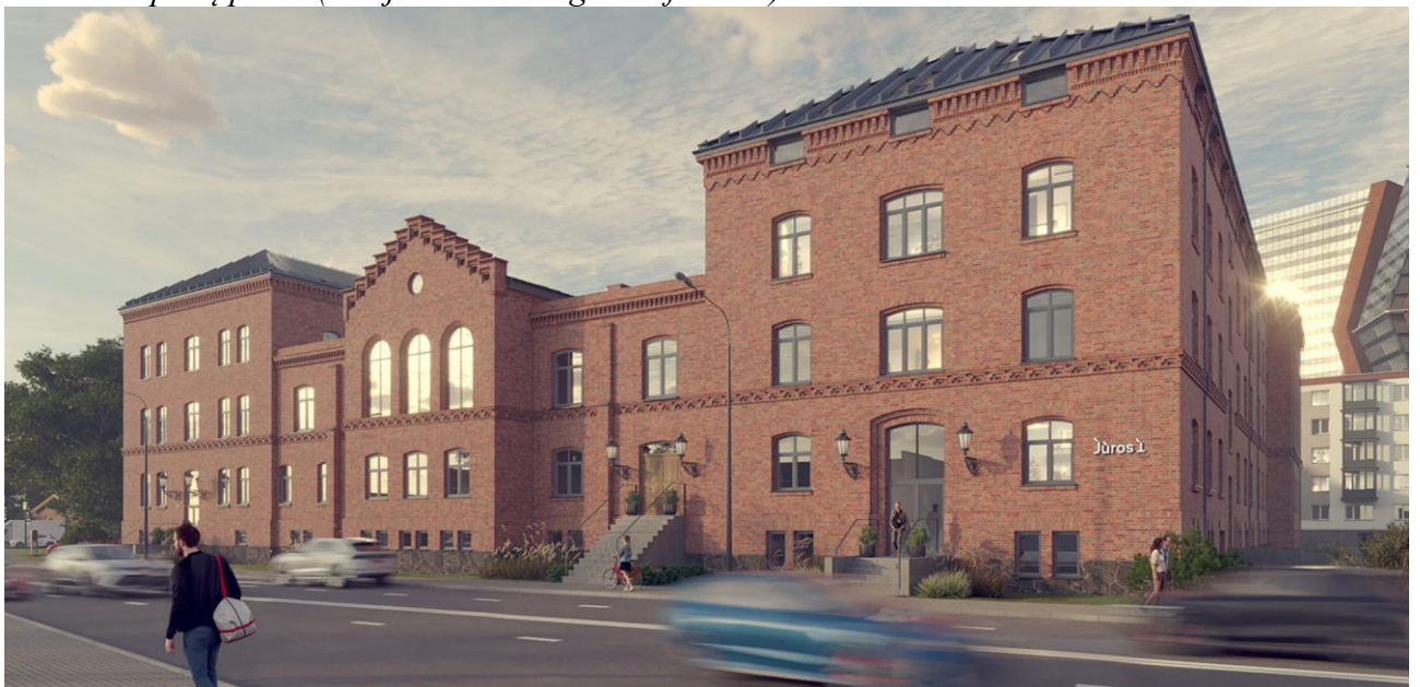
Vaizdas iš pietų pusės (Naujosios Uosto gatvės fasadai)
