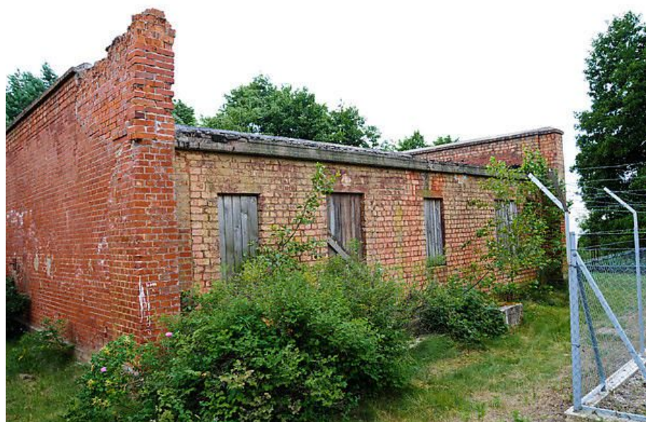
10. Nemirsetos laivų gelbėjimo stoties permūrytas šiaurinis fasadas
