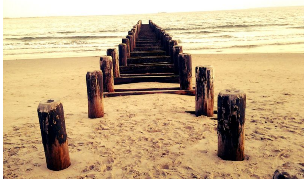
7.28 pav. Buna iš dviejų polių eilių
