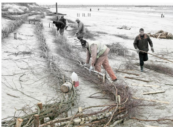
7.27 pav. Žabtvorių įrengimas paplūdimyje
