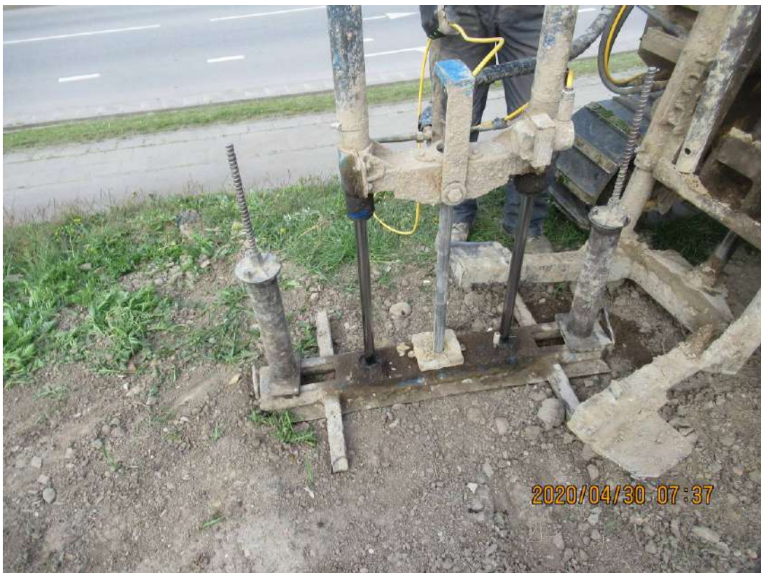
Nuotrauka Nr. 4. Inžineriniai geologiniai tyrimai šlaito viršuje.
